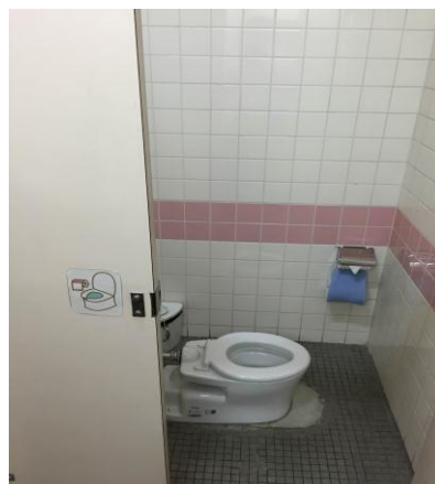
改修した洋式トイレ (幼児用サイズ)
