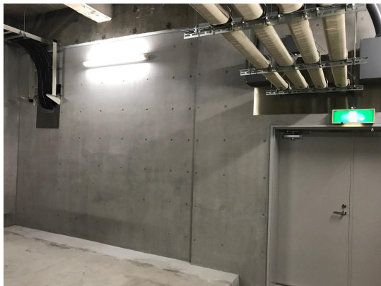
* 耐震補強工事 中央図書館の地下に設置した耐震壁
