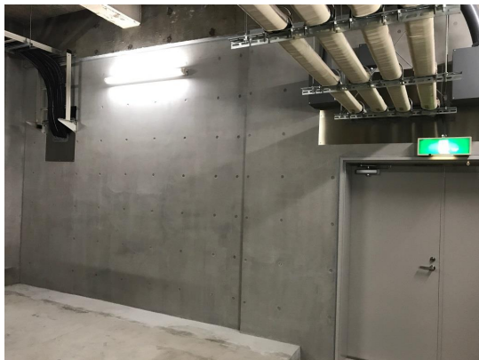
* 耐震補強工事 中央図書館の地下の設置した耐震壁
